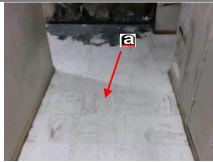
Photo n° PhA001 Localisation : Palier Ouvrage : 5 - Planchers et planchers techniques - Revêtements de sols Partie d'ouvrage : Dalle de sol Description : Dalle de sol
