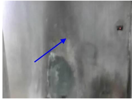
Photo n° PhA002 Localisation : Palier Ouvrage : 3 - Parois verticales intérieures - Murs et cloisons maçonnés Partie d'ouvrage : Enduit à base de plâtre lissé ou taloché Description : Enduit à base de plâtre lissé ou taloché
