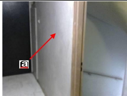
Photo n° PhA003 Localisation : Palier Ouvrage : 3 - Parois verticales intérieures - Cloisons sèches (assemblées, préfabriquées) Partie d'ouvrage : Enduits à base de plâtre ou ciment projetés, lissés ou talochés Description : Enduits à base de plâtre ou ciment projetés, lissés ou talochés
